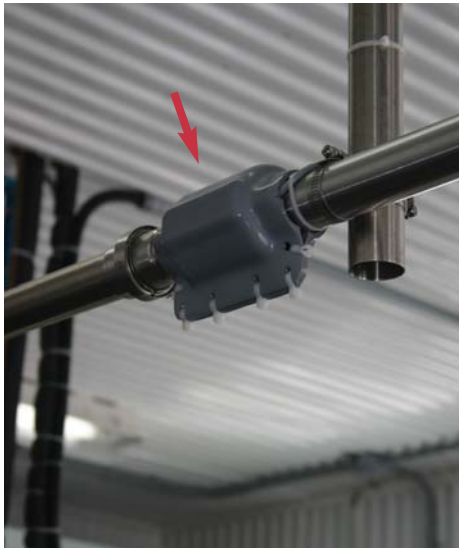
Ce sont les sondes qui envoient l'information au thermographe.
